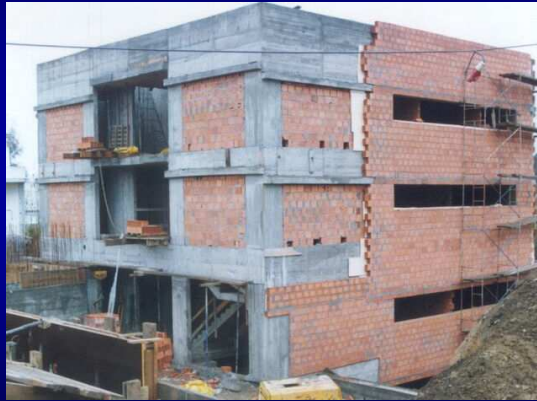
Alvenaria de tijolo vazado – Solução “tradicional” de paredes
