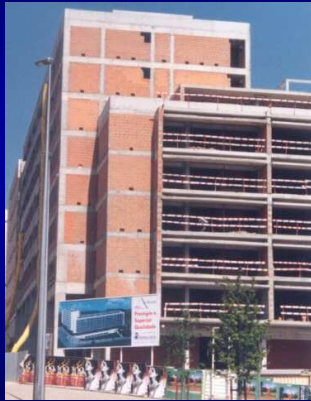
Alvenaria de tijolo vazado – Solução “tradicional” de paredes
