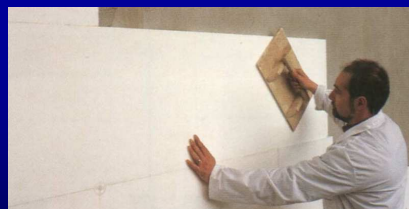
Aplicação do sistema – Colocação das placas de isolamento
